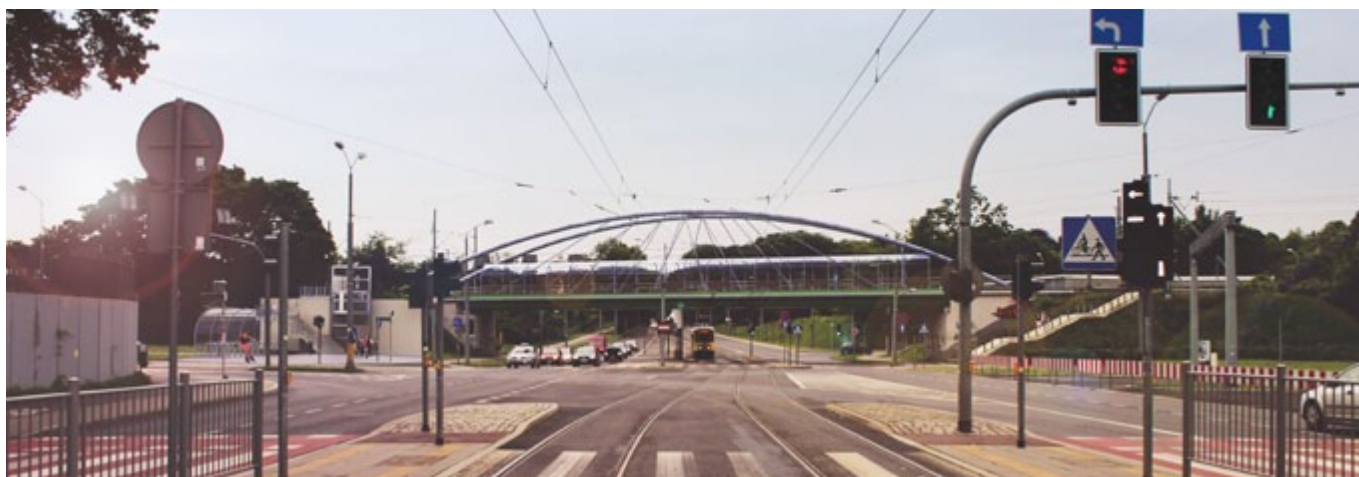
Fot. 4. Zrealizowany wiadukt Szczecińskiej Kolei Metropolitalnej nad ul. Arkońską
