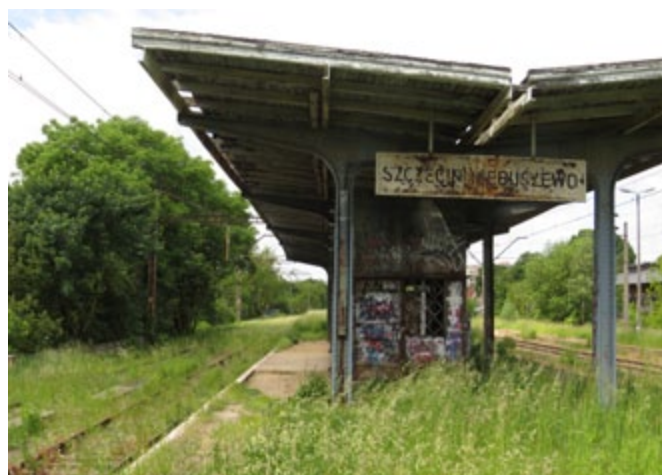
Fot. 3. Stan istniejący peronu Szczecin Niebuszewo
